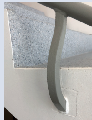
Ingjutet räckesfäste.
