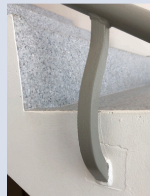
Ingjutet räckesfäste.
